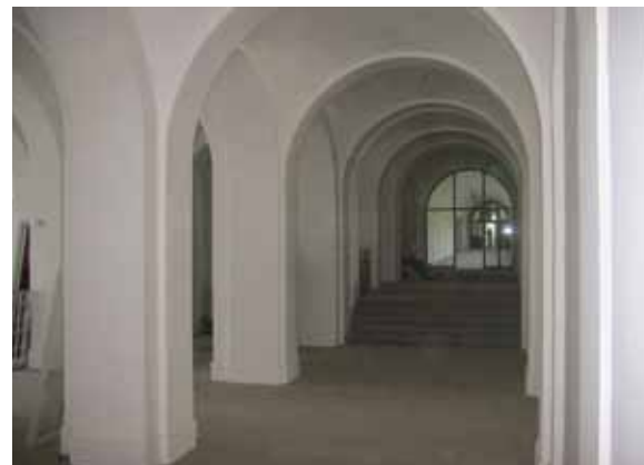
Nachträgliche Veränderungen des 20. Jahrhunderts mussten mühevoll wieder rückgeführt werden / Subsequent alterations carried out in the 20th century had to be removed with some difficulty © Irena Krajnc Horvat, Denkmalamt Maribor
