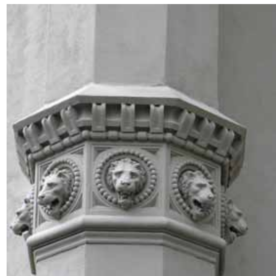
Die eigens in einer Fabrik in der Nähe von Wien erzeugten Tonelemente stellen einen zentralen Anteil der architektonischen Gliederung dar / The clay elements produced specially in a factory near Vienna represent a central part of the architectural arrangement
