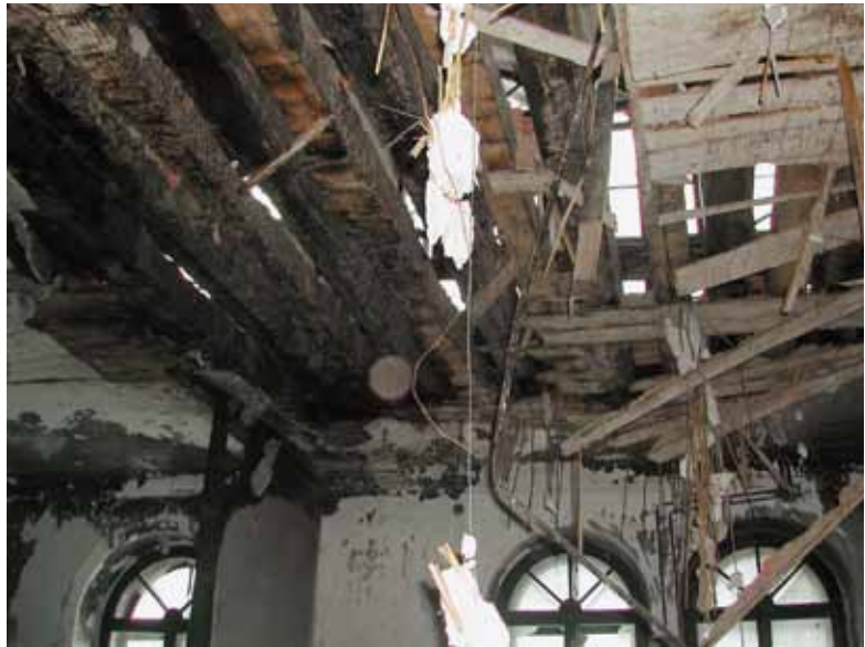
Die Größe des Gebäudes sprach trotz des desolaten Zustandes für eine Generalsanierung und militärische Verwendung / In spite of the desolate state of the building its size favoured general refurbishment and a military use
