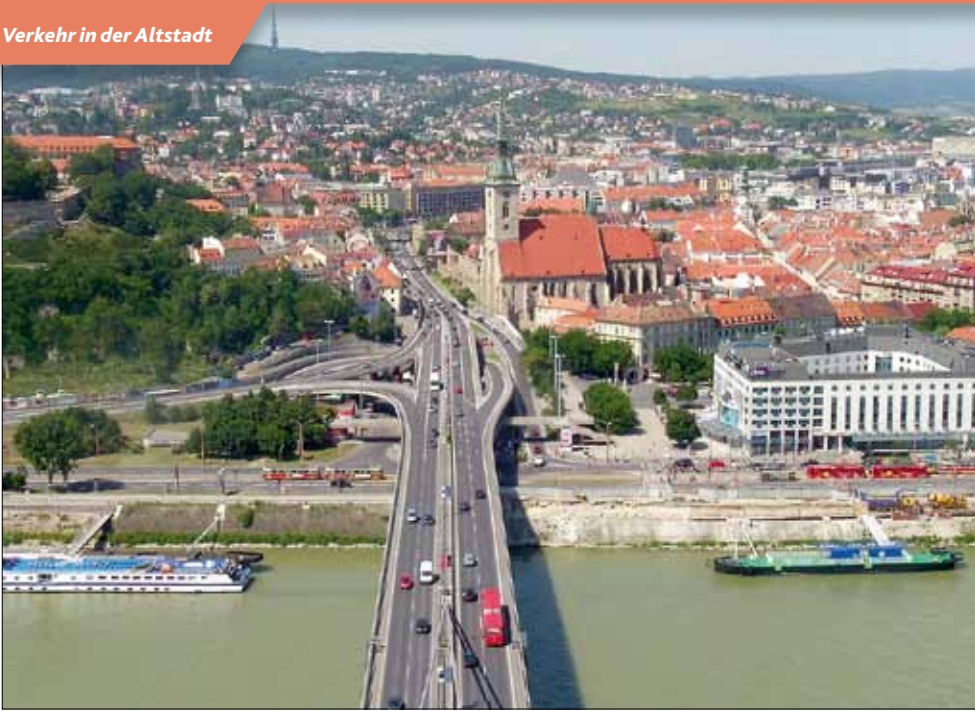
Abb. 4: Der wichtige vierspurige Verkehrsweg führt direkt im Graben an der mittelalterlichen Stadtbe- festigung vorbei. Teile der Stadt- mauer waren in den 70er Jahren rekonstruiert worden. In der Ba- rockzeit war der Graben bebaut. Ill. 4: The major four-lane highway runs directly along the moat alongside the mediaeval city fortifications. Parts of the city walls were re- constructed in the 1970s as the moat had been filled in and built on in the Baroque period
