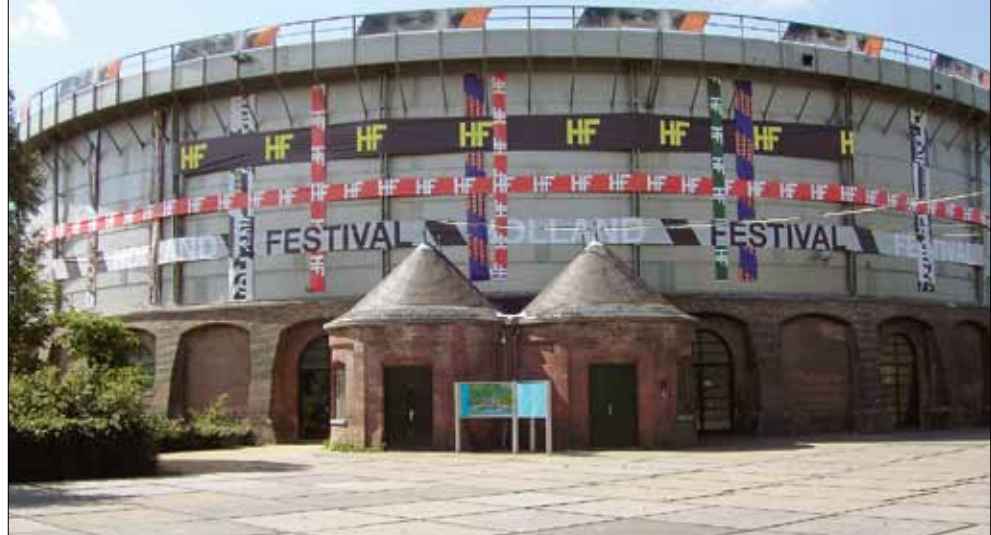
Westergasfabriek, ehemaliger Gaskessel, heute multifunktionaler Veranstaltungssaal Westergasfabriek, former gasometer, now a multifunctional event hall © Resch /Uray-Frick
