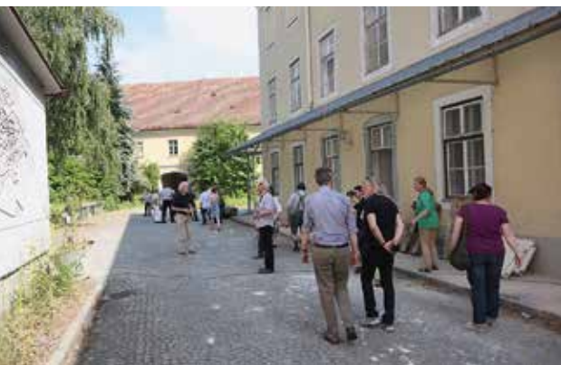
Ehemalige Tabakfabrik auf einer Renaissancebastei in Fürstenfelds Altstadt | Former tobacco factory situated on a Renaissance bastion in the historic centre of Fürstenfeld © ISG
