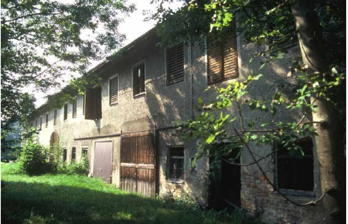
Der alte Pfarrstadel vor dem Umbau The old rectory barn before the conversion
