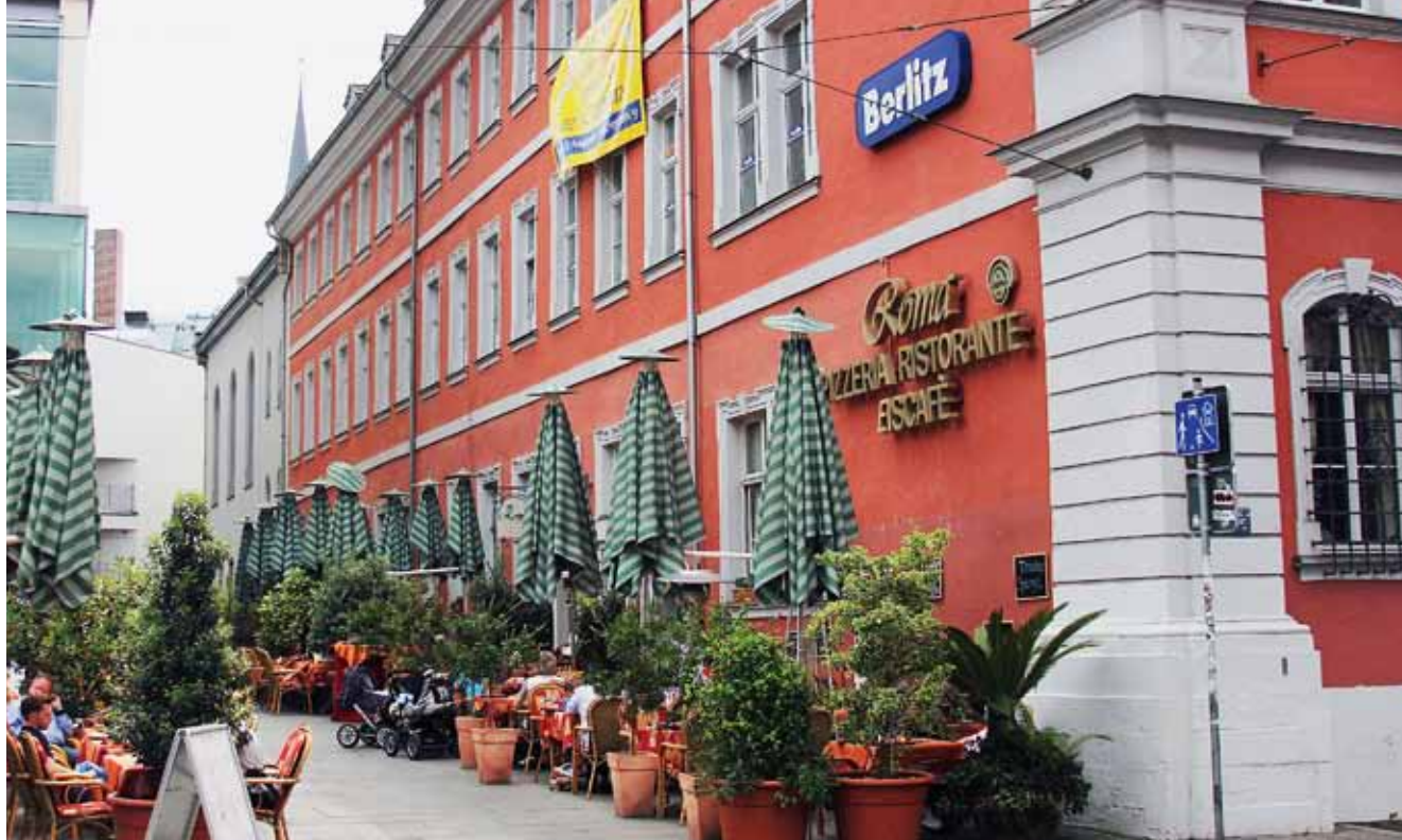
Genehmigte Werbung und unzulässige Werbepläne an einer Fassade Authorized advertising and inadmissible advertising tarpaulins on one façade
