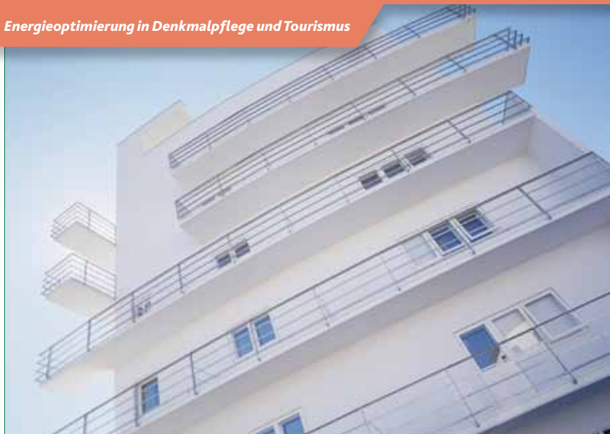
Rekonstruktion der auskragenden Balkone. Reconstruction of the projecting balconies.
