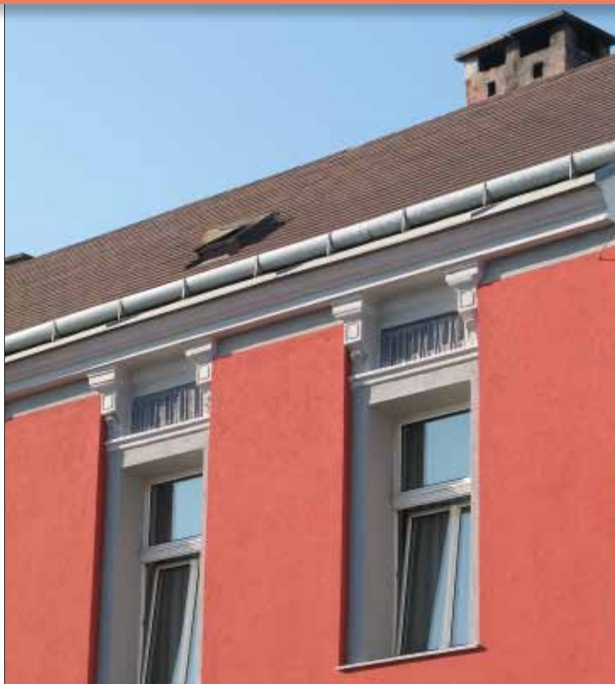
Ergebnis der nachträglichen Außendämmung einer ursprünglich reich gegliederten Fassade. Result of exterior insulation fitted retroactively on a facade which was originally rich in structure.
