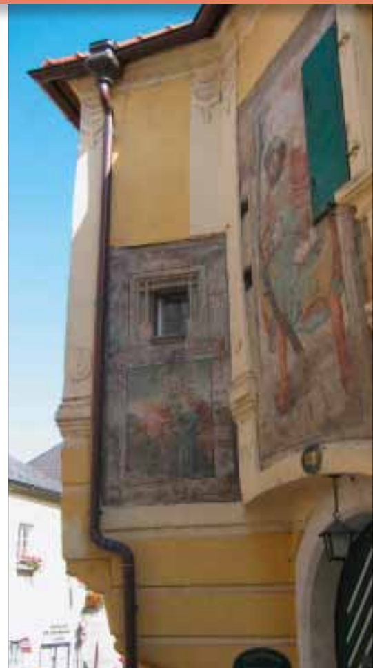
Heterogene Fassade mit mehreren Zeitschichten; Außendämmung ausgeschlossen. Heterogeneous facade with several layers; exterior insulation not possible.
