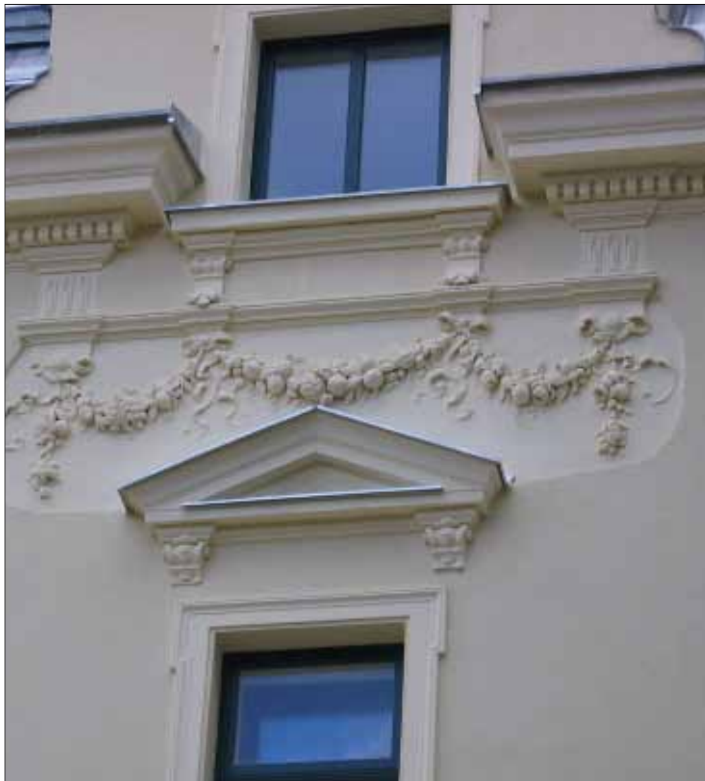
Aussparung im Dämmputz als Sichtfenster zur historistischen Fassade. Recess in the insulating plaster as a visual plane on the historic facade.
