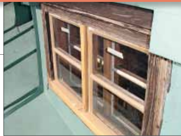
Bergstation Hafelekar, Fenster während der Sanierung Dezember 2006: Ausgetauscht wurden nur die wirklich schadhafte Teile. Window during renovation at the mountain station Hafelekar in December 2006: only the damaged portions were replaced.
