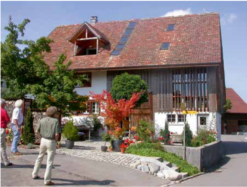
Winterberg (Kanton Zürich), ausgebauter Scheunenteil mit beweglichen Lamellen als Fassadenverkleidung Winterberg (Canton of Zurich) extended part of a barn with adjustable slats as facade covering
