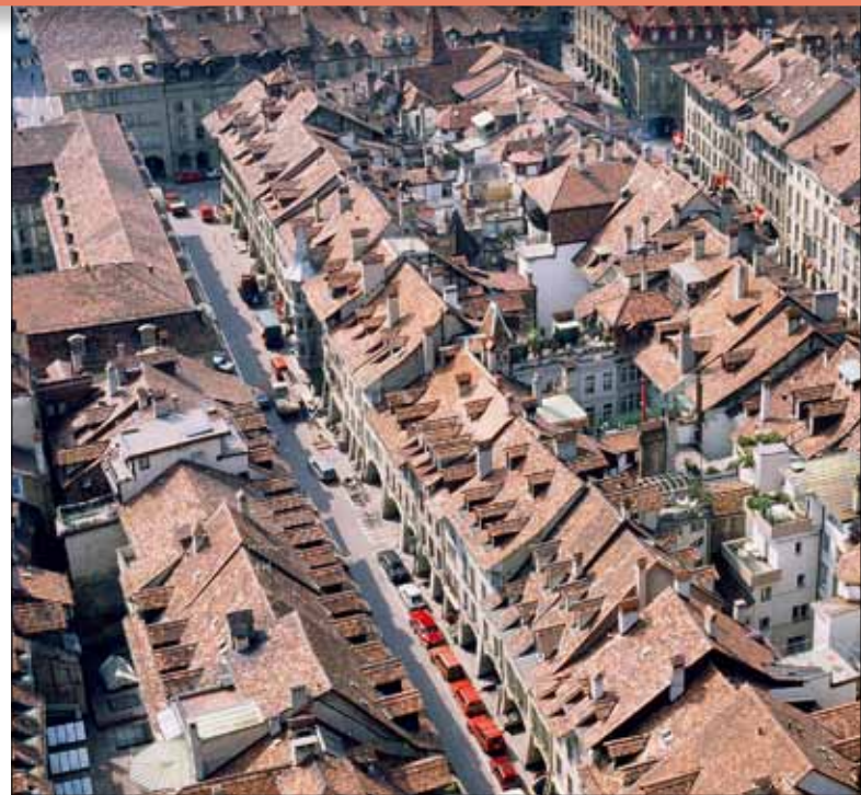
Die untere Altstadt, die in den Erdgeschossen kleinere Geschäfte aufnimmt und in den Obergeschossen bis heute vornehmlich einer Wohnnutzung vorbehalten ist
