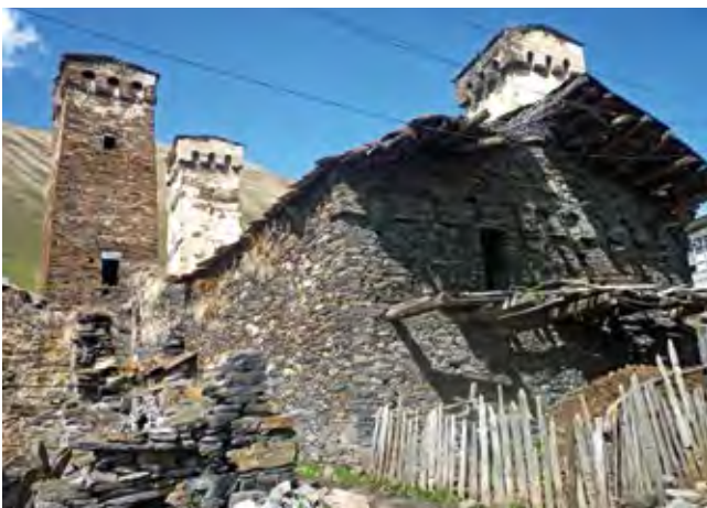
Typische Bautypologie - Turm und anliegendes Haus
