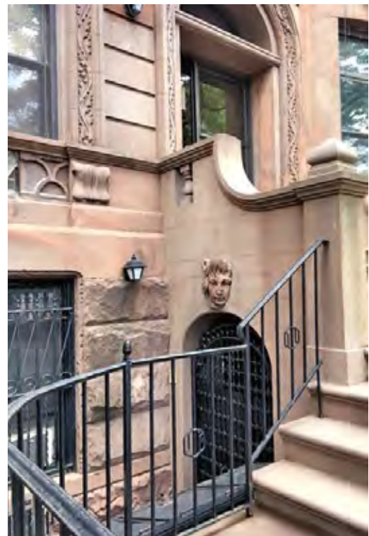
Eingangsbereich eines Sandsteinhauses, 179 West 79th Street, New York, ca. 1870-1890 errichtet
