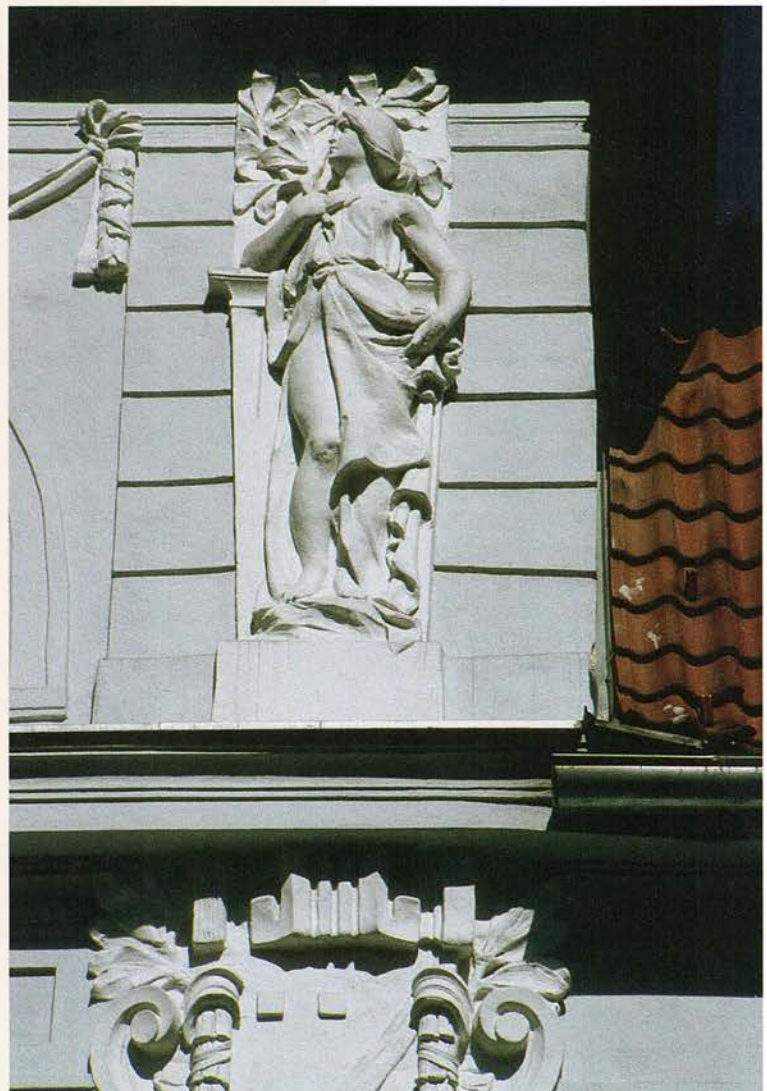
Behutsam wurde ein Jugendstilhaus in Bruck/Mur saniert. Foto: Hasso Hohmann
