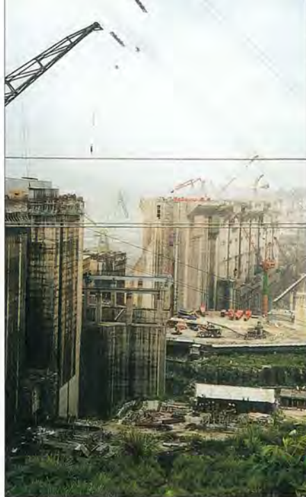
Die Baustelle. Fotos: Hilmar Zetinigg
