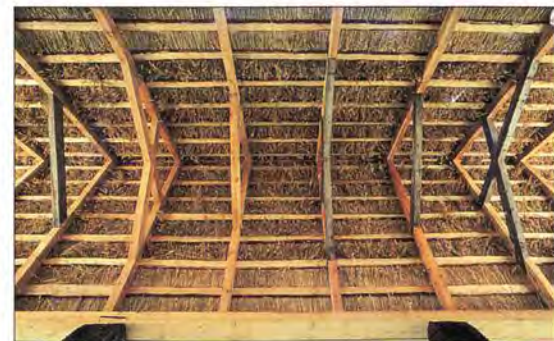
Die Dachuntersicht belegt, daß nur wenige Originalhölzer in dieser Zone der Brücke wiederverwendet werden konnten.
