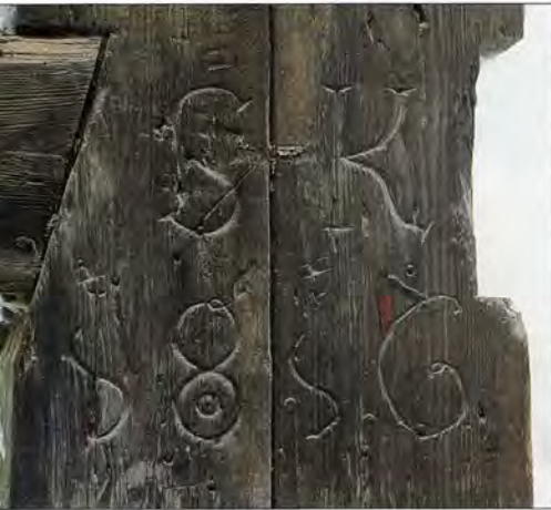
Die Jahreszahl 1816 an der Innenseite der ursprünglichen Abhängung vom Sprengwerk der Brücke gibt das Alter der heutigen Konstruktion an; eine ähnliche Brücke ist hier schon wesentlich früher belegt.
