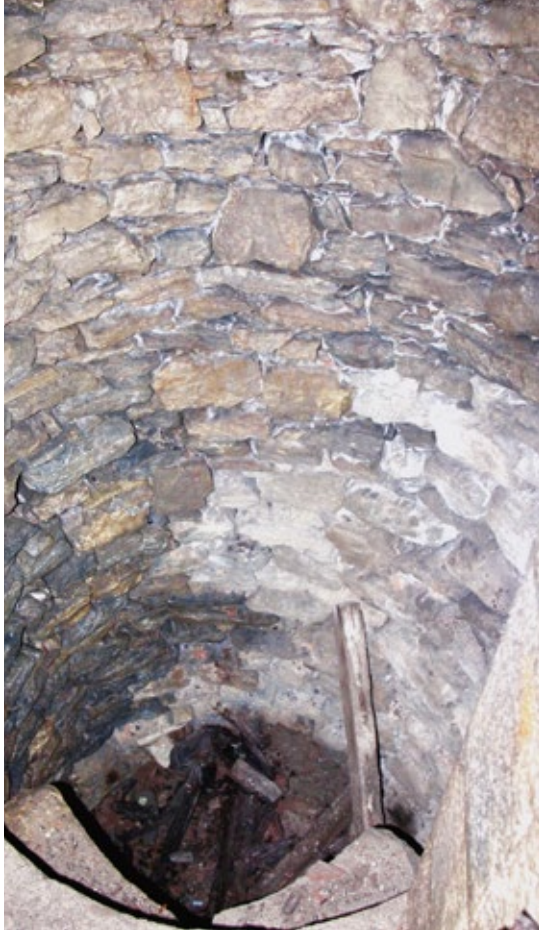
Sohle des Brunnenschachts
