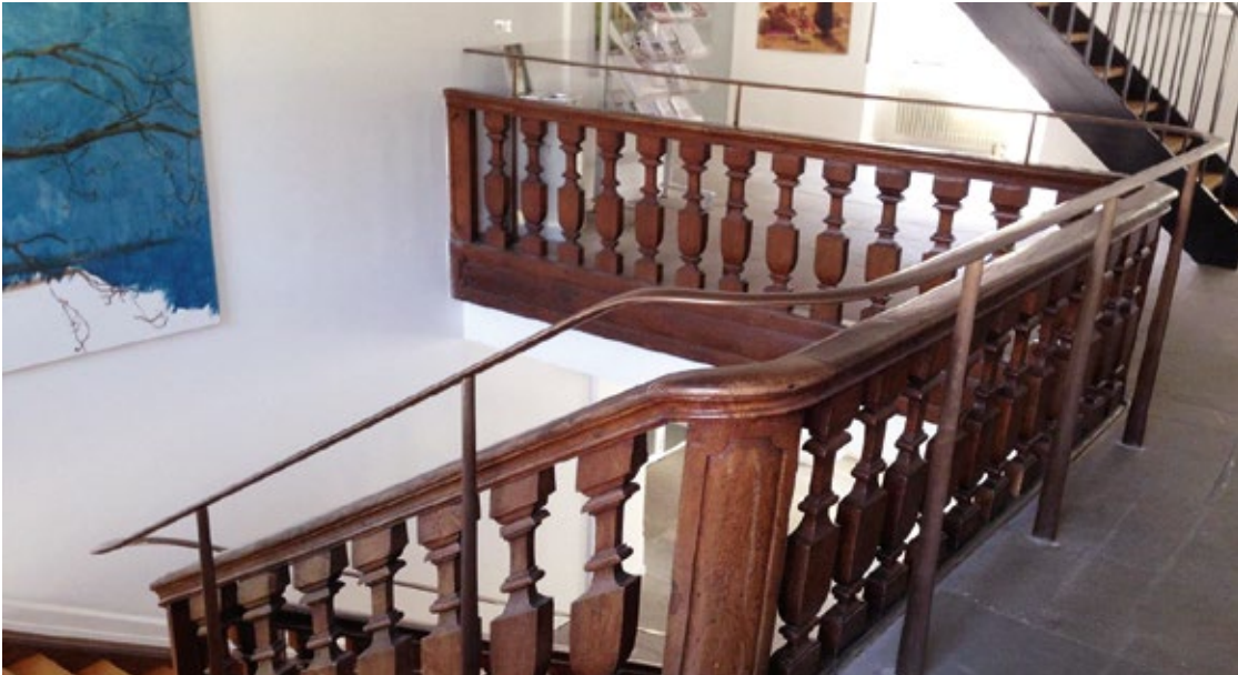
Barocktreppe des Heiliggeistspitals Luzern
