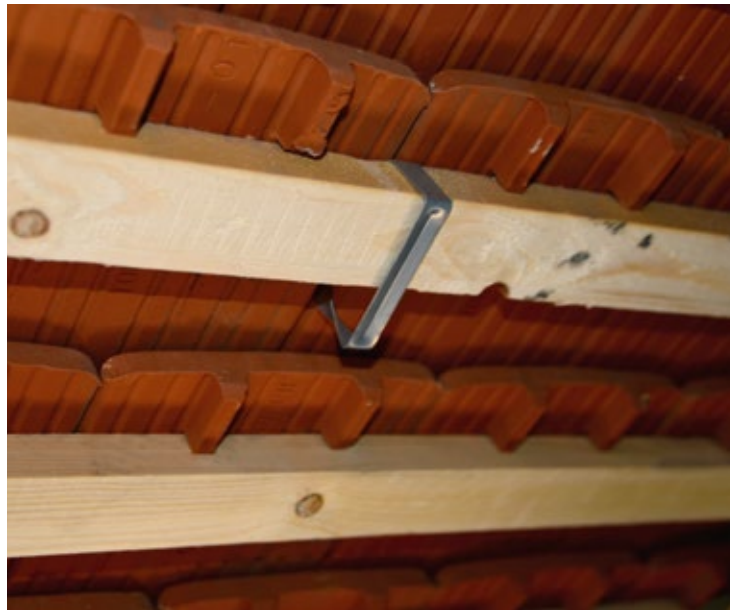
Klammer ermöglicht eine gute Dachbefestigung
