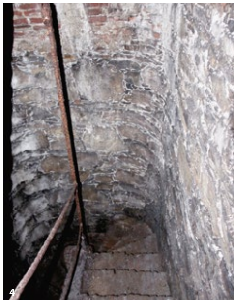
[3] Brunnenschacht durch den rundbogigen Abschluss über der Brunnensohle
