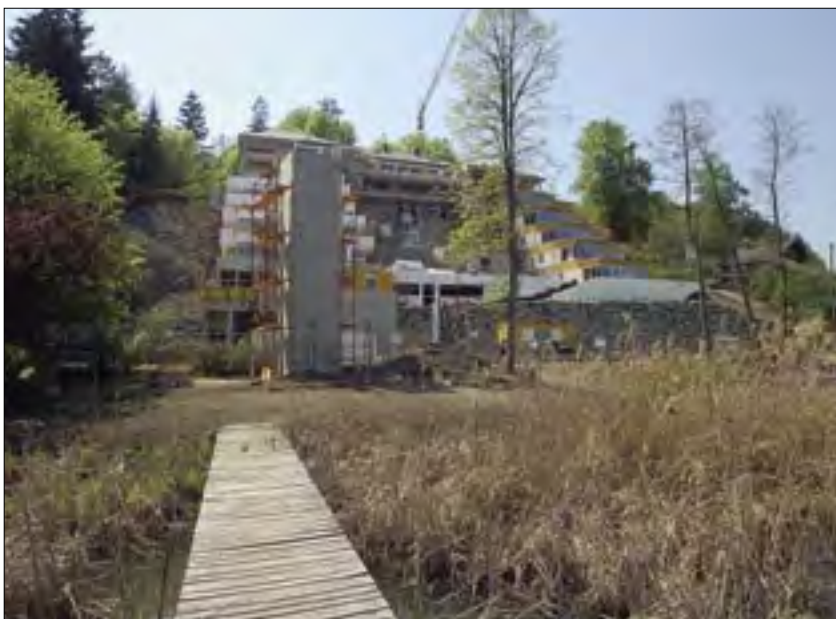
Das von einem Klagenfurter Baumeister geplante Apartmentensemble von einem alten Steg im Wörthersee aus fotografiert. Man sieht den Lift- und Treppenturm im Vordergrund, der mit einer Brücke über die Uferstraße an die Apartments andockt.
