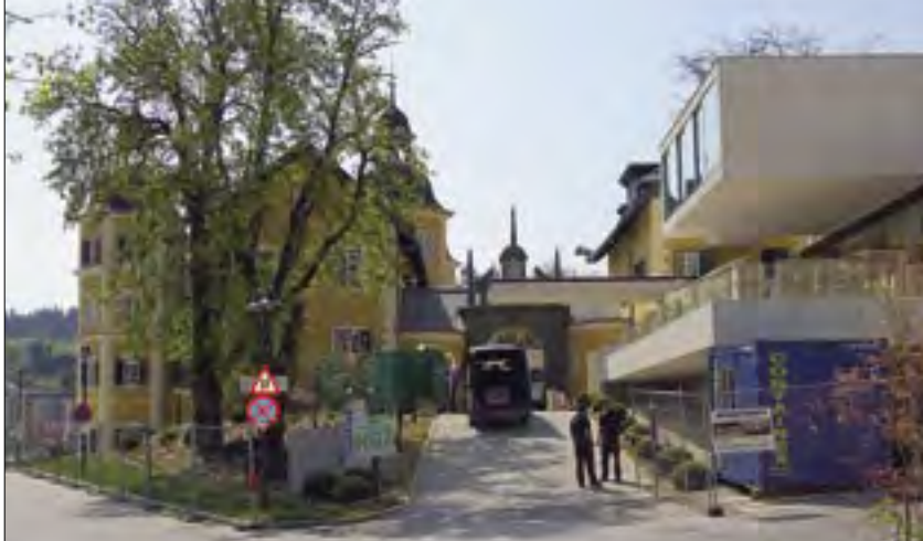
Die Anschlüsse an die Nebengebäude bei der Hofauffahrt stören in der Großform und im Detail.
