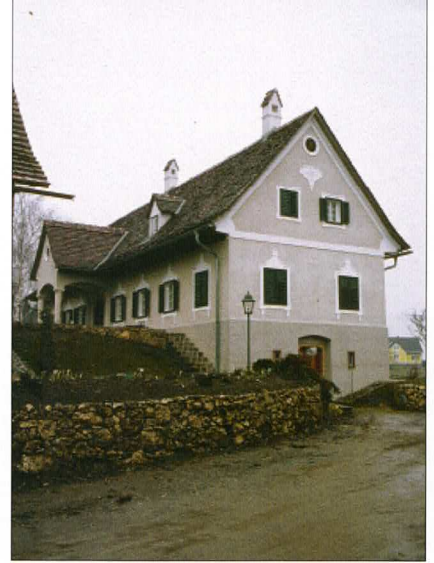
Das biedermeierliche sanierte Wohnhaus.
