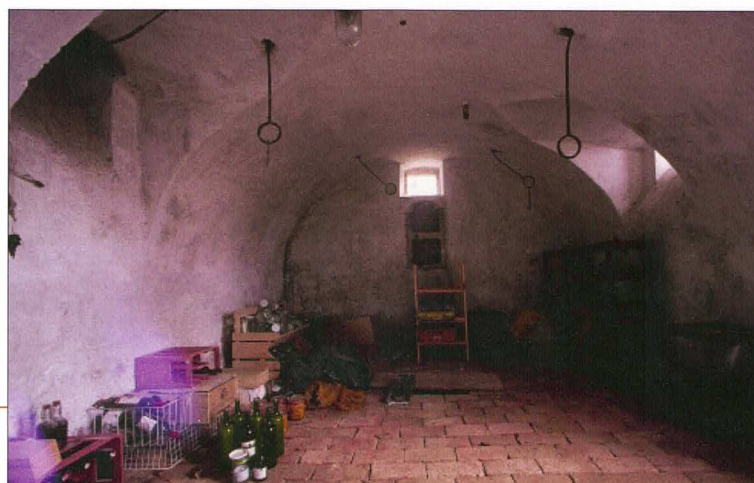
Eines der mächtigen Tonnengewölbe im Kellerhaus.
