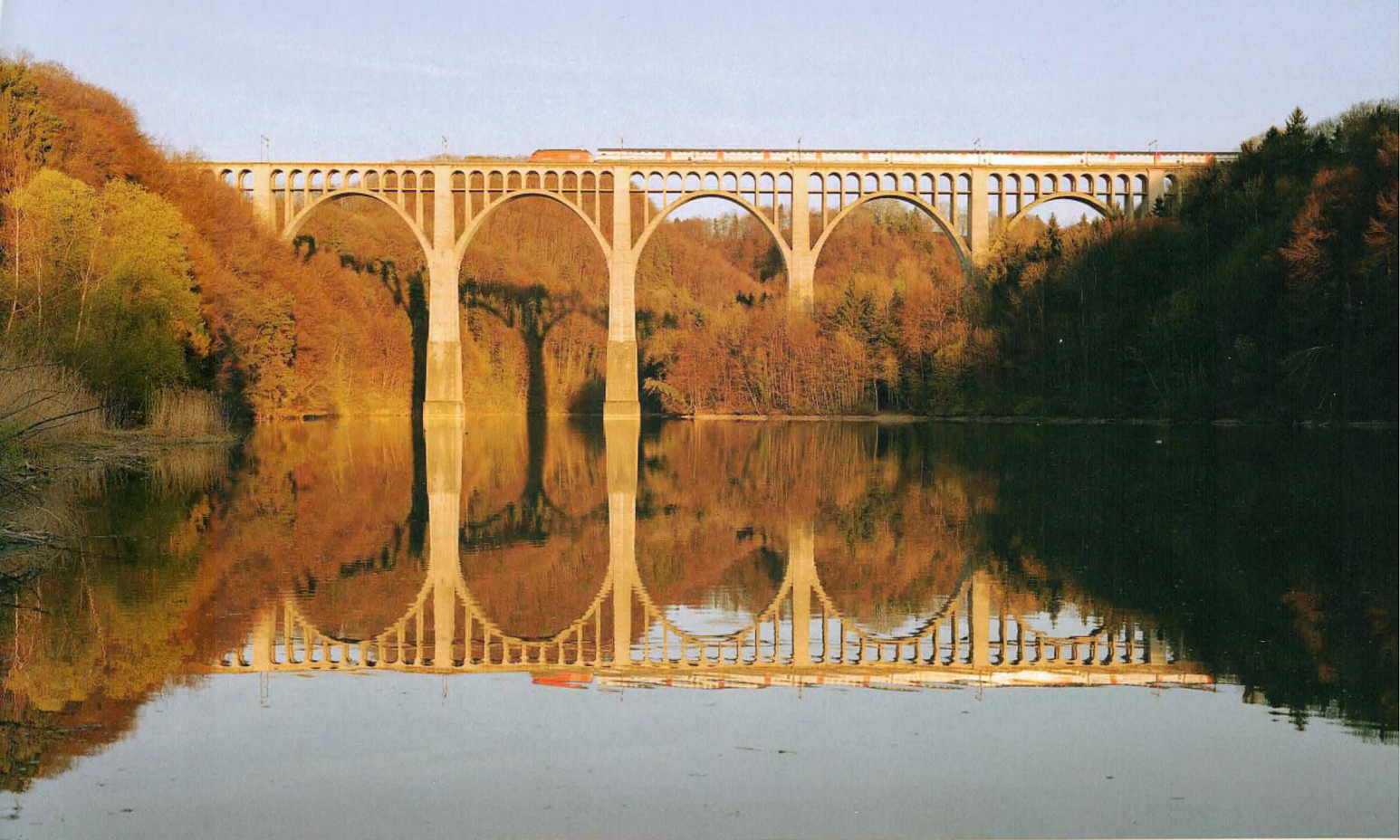
Grandfey-Viadukt, Freiburg: Die Saanebrücke aus dem Jahre 1862 war ursprünglich aus Eisen; 1927 wurde sie einbetoniert, da für die schweren elektrischen Loks die Fachwerkträger nicht mehr genügten.
