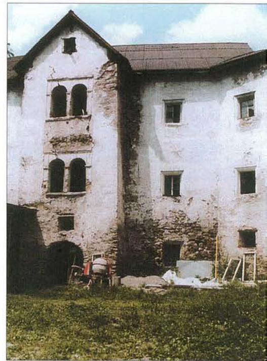
Das Wedam-Schlössl vor der Sanierung. Foto: Hans Rathmann
