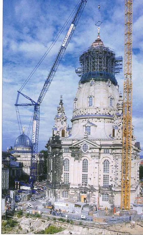
Aufsetzen der Laternenhaube am 22.06.2004.
