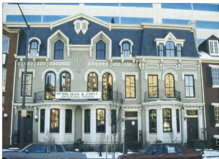
Fassaden einer Häuserzeile des ausgehenden 19.Jh. in Washington D.C. , die auf Grund von Bürgerprotesten erhalten wurde. Unmittelbar hinter den Dächern schliesst eine Flachdachterrasse an, die zu einem glatten hohen Bürohochhaus überleitet. Die Fenster der alten Hausfassaden sind verspiegelt.
