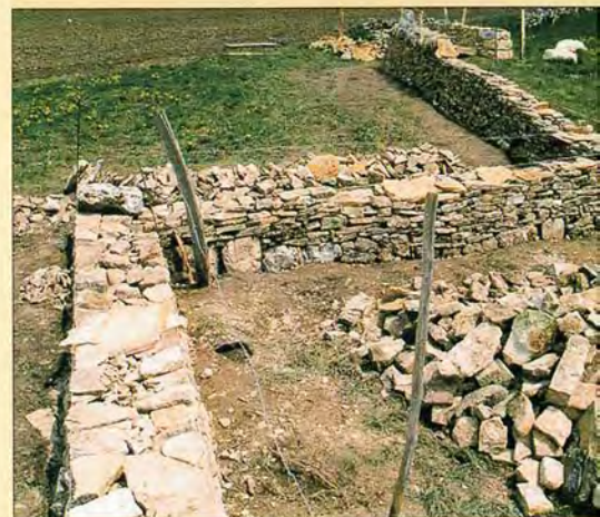
Wiederherstellung einer Trockenmauer in Le Bémont.
