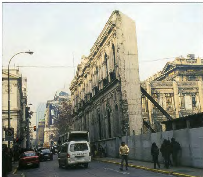
Historisches Bauwerk im Stadtkern von Santiago de Chile , das vollständig ausgeweidet wurde, um es mit einem neuen Bauinhalt anzufüllen.
