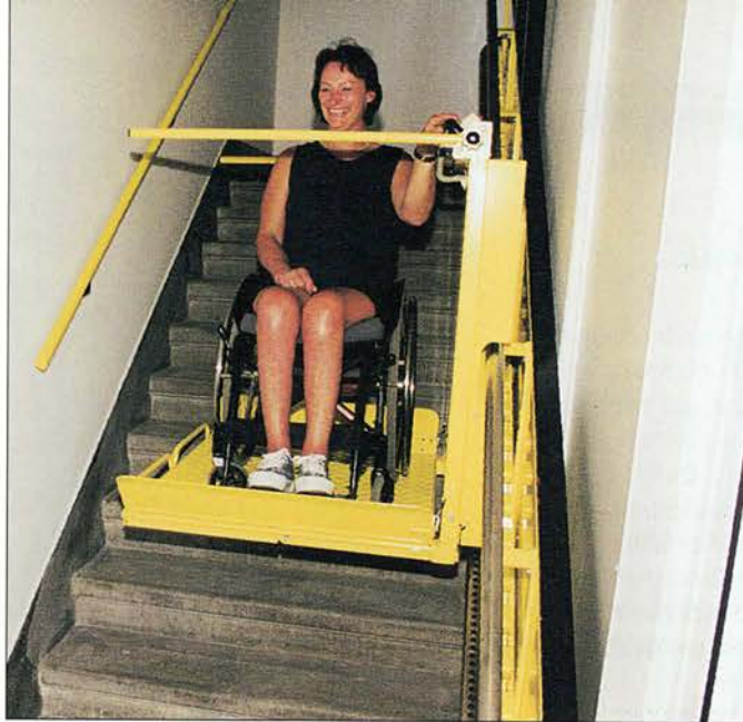
Schrägaufzug für den Rollstuhl über der Treppe.
