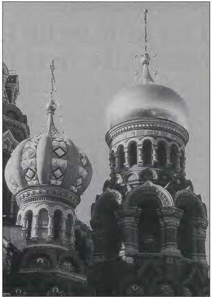
Oben: Die Außensanierung der „Christi Auferstehungskirche“ ist abgeschlossen.
