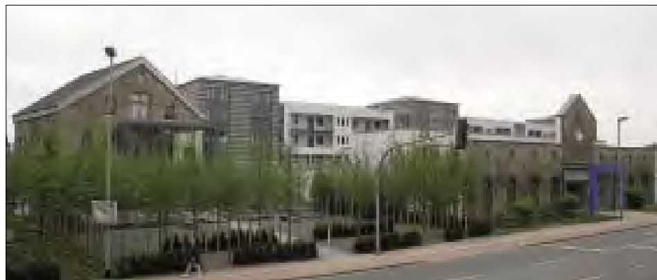
Eine Besonderheit stellt der Umgang mit der Historie des Gebietes dar; so wurde eine erhaltenswerte historische Fassade der ehemaligen Betriebsgebäude in die Neubebauung integriert. Das frühere Werkstor stellt heute den Zugang zu den Einzelhandelsflächen dar. Diese Eingangssituation und die dahinter liegende Wohnbebauung sind hier dargestellt.
