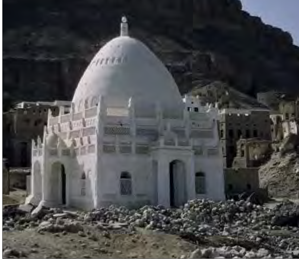
Bei diesem jemenitischen Sakralbau bei Sejun im Wadi Hadramaut wechseln Blendgitter und echte Gitter als Brüstungen.
