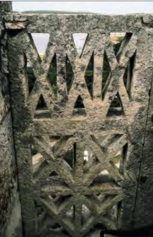
Diese Transennen aus Naturstein, am großen Amphitheater von Pula in Istrien eingesetzte Gitter, hatten Vorbilder aus Ziegel oder Holz.
