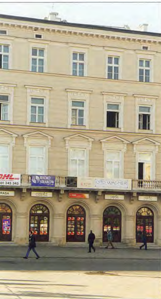
Fassade des Hauses "Zu den Raben".
