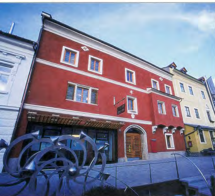
Das rote Rathaus in Murau im sanierten Zustand.
