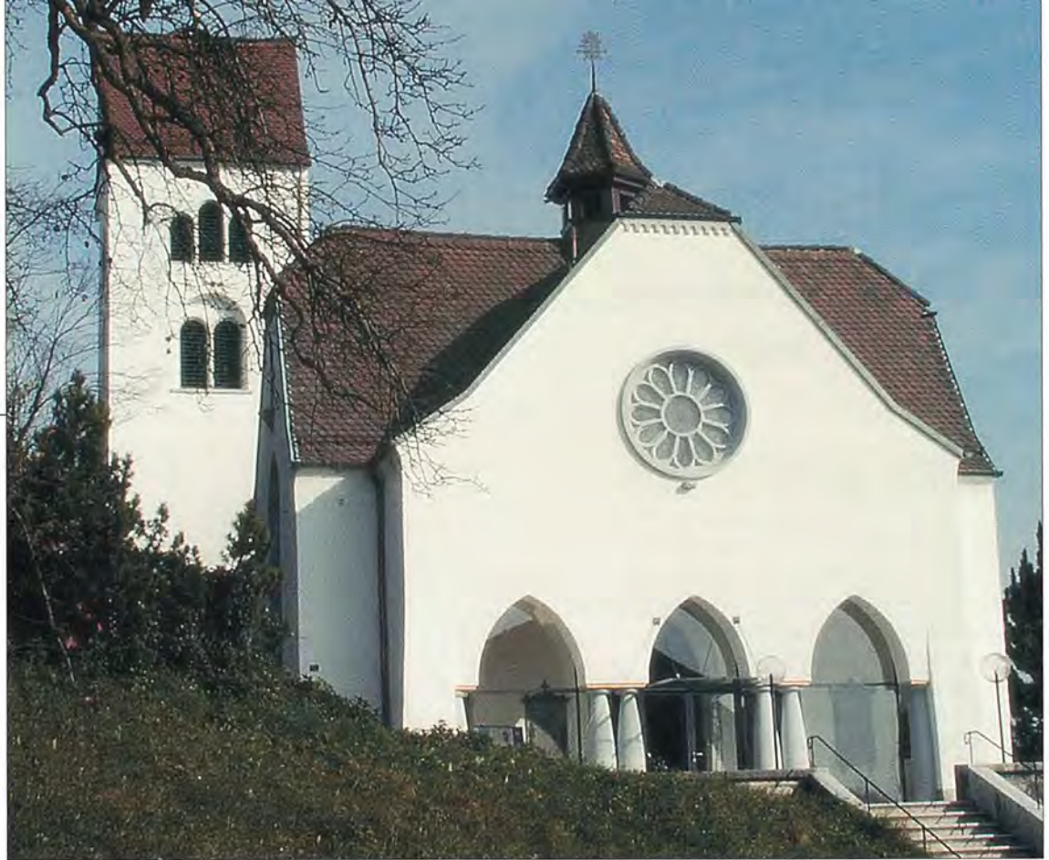
Fassade nach der Restaurierung.
