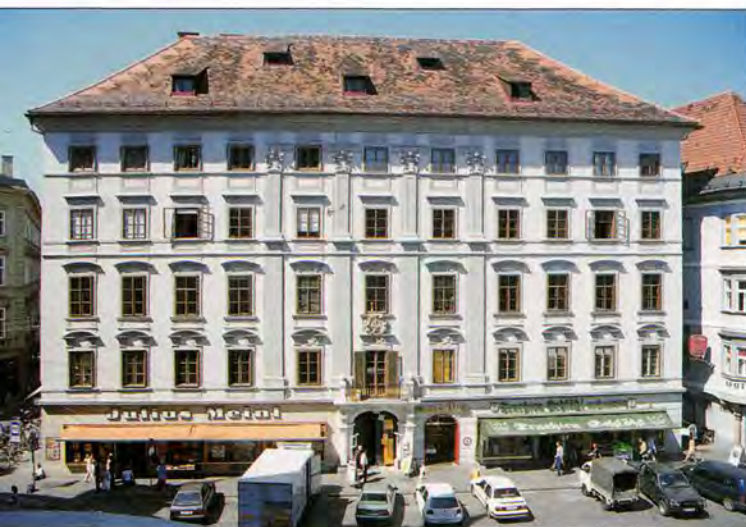
Das Weiß'sche Haus, das inzwischen unter Denkmalschutz steht, knapp vor Abschluß der Renovierung.
