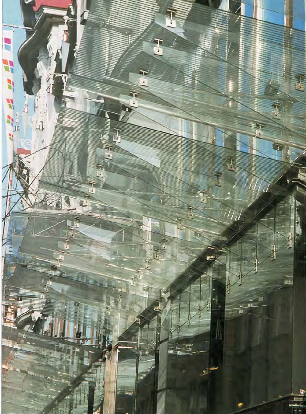
Gelungenes Beispiel in der Grazer Altstadt: Moderne Glasfassade des Kaufhauses Kastner & Öhler (Planung: Architekturbüro Szyszkowitz-Kowalski).
