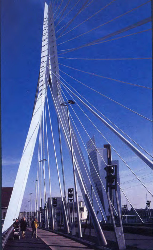
Erasmus-Brücke in Rotterdam (Ben van Berkel; 1990-1996).
