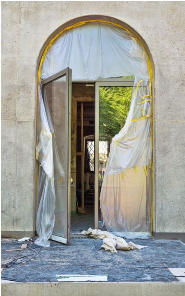
Blick durch einen Arkadenbogen in den Hörsaal
