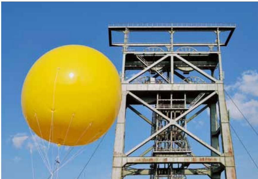
Fördergerüst der Zeche Gneisenau bei der Aktion „Schachtzeichen“ im Rahmen der Kulturhauptstadt Ruhrgebiet 2010 Shaft tower at Gneisenau colliery as part of the event „Schachtzeichen“ during the European Capital of Culture Year © I. Wiese-von Ofen
