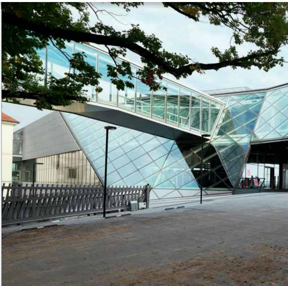
Der neue Südflügel ergänzt das Ensemble des historischen Linzer Schlosses wieder zum vollständigen Ganzen und ermöglicht den geschlossenen Museumsrundgang durch Alt und Neu.
