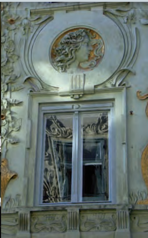
Für die Altstadt einzigartige florale Jugendstil-Stuckfassade um 1900 in der Sporgasse. A unique floral Art Nouveau stucco façade in the historic centre (Sporgasse) dating from about 1900.
