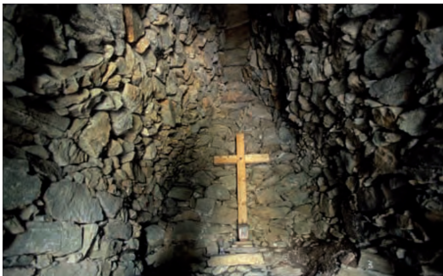
Die Innenansicht der Glattjochkapelle zeigt neben dem modernen Kreuz seitlich das Kraggewölbe und oben die Decksteine.
