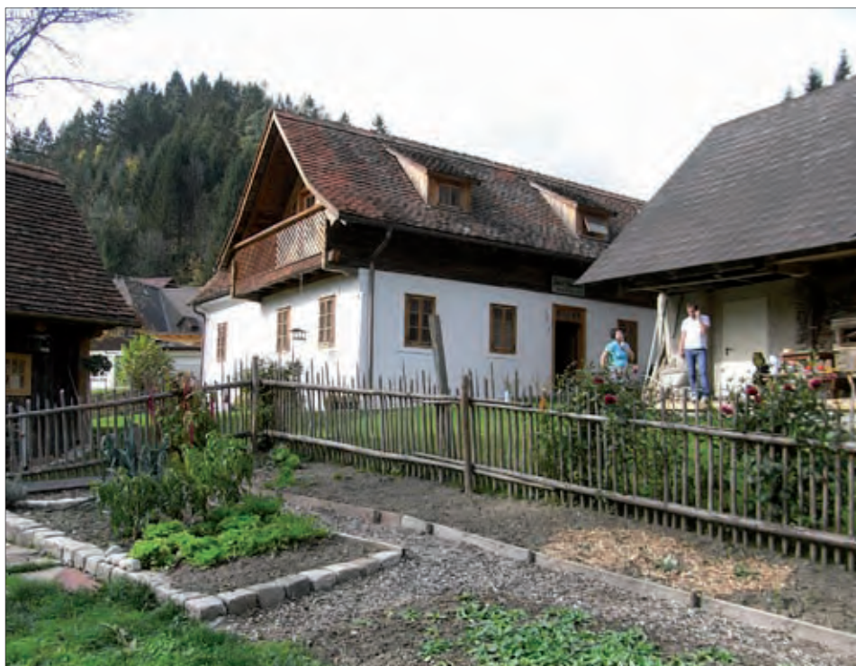
Das sanierte Anwesen.
