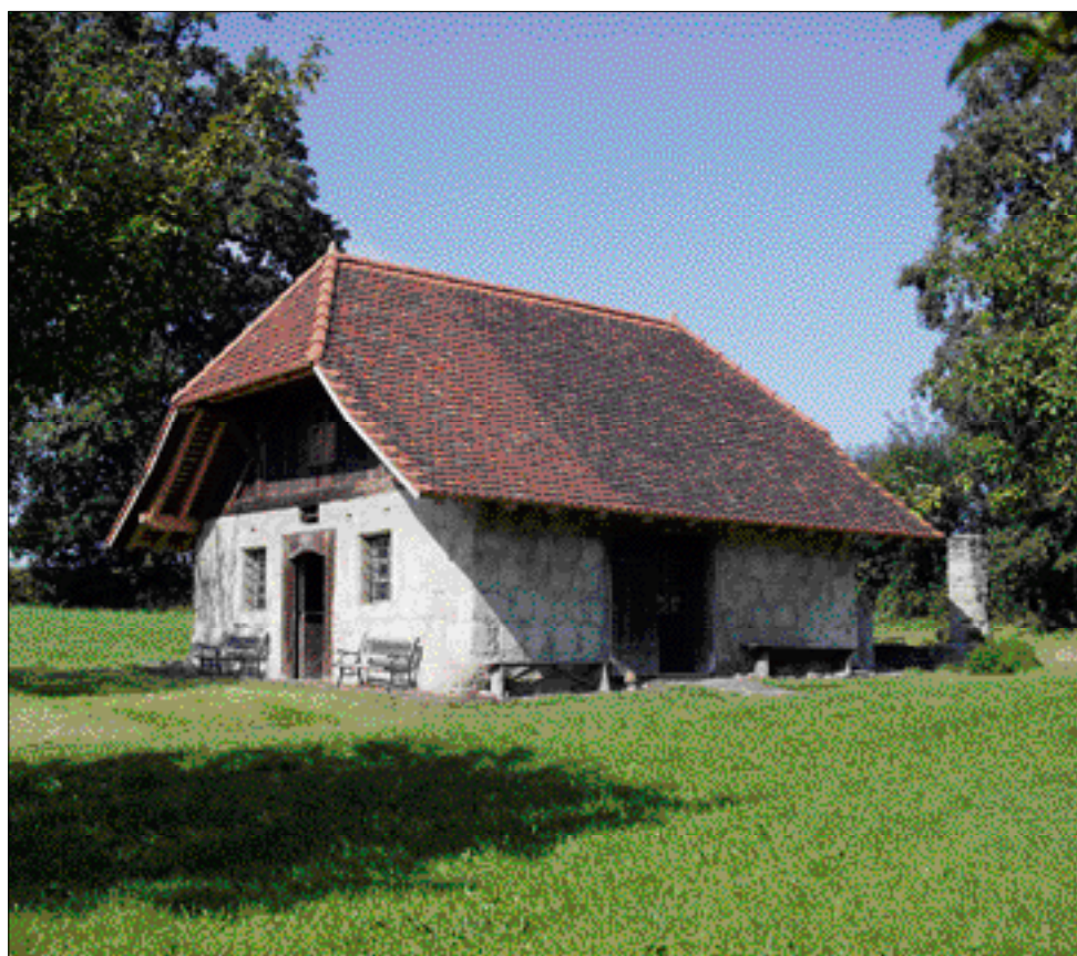
Vor kurzem restauriert: Das ehemalige „Ofenhaus“ in Lustorf (Kanton Fribourg) ist typisch für die hiesigen Bauernweiler.
