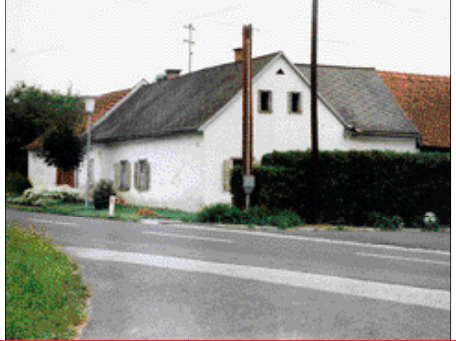
Die Westfassade des noch nicht sanierten Vierseithofes ist zugleich die Straßenseite.
