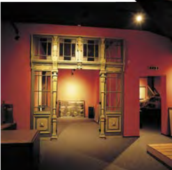
Die Deutsche Stiftung Denkmalschutz unterstützte auch die Sanierung dieser gründerzeitlichen Tür.
