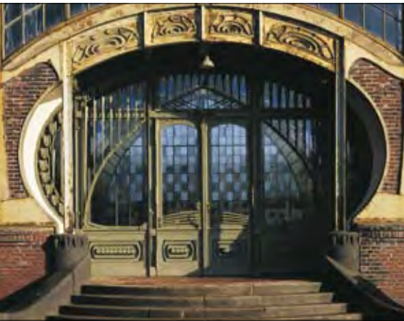
Jugendstilportal der Maschinenhalle.
