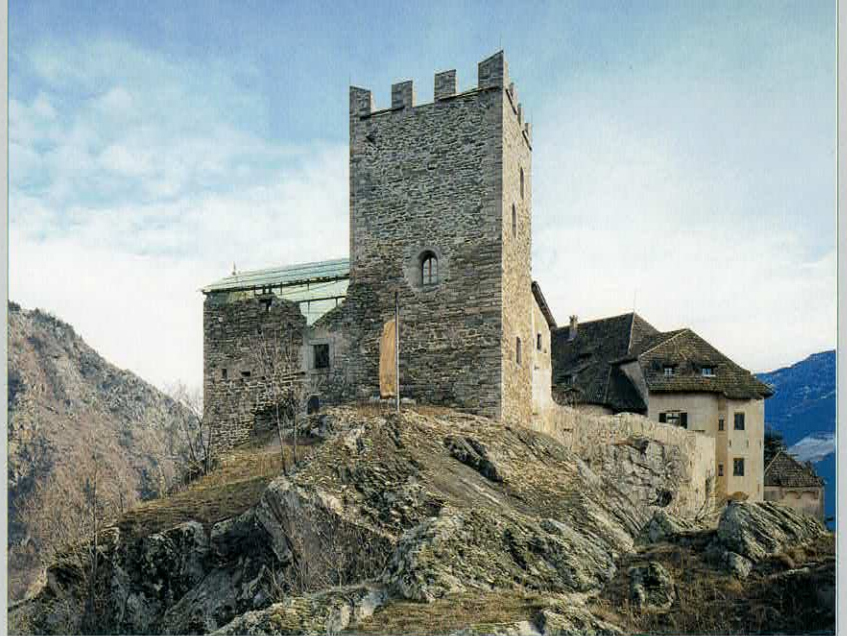
Blick auf den adaptierten Teil der Burgranlage von Juval mit dem transparenten Satteldach aus Glas.
