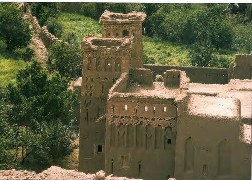
Draufsicht auf einen Teil einer Kasbah mit unterschiedlichen Reliefarten.
