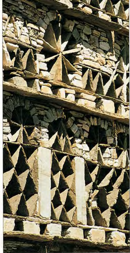
Detail eines Taubenhauses; Mauerwerk und Blendgitter sind als Trockenmauerwerk ausgebildet; nur die kleinen quadratischen Löcher über den vorstehenden horizontalen Steinplatten führen für die Tauben ins Innere.
