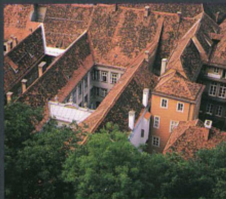
Ein Hochgenuß vom Schloßberg aus: Die reizvolle Dachlandschaft.
