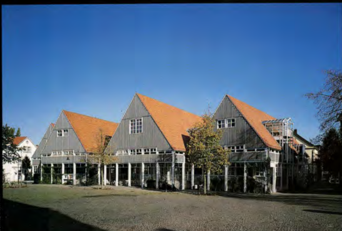
Stadthaus in Rheda- Wiedenbrück
