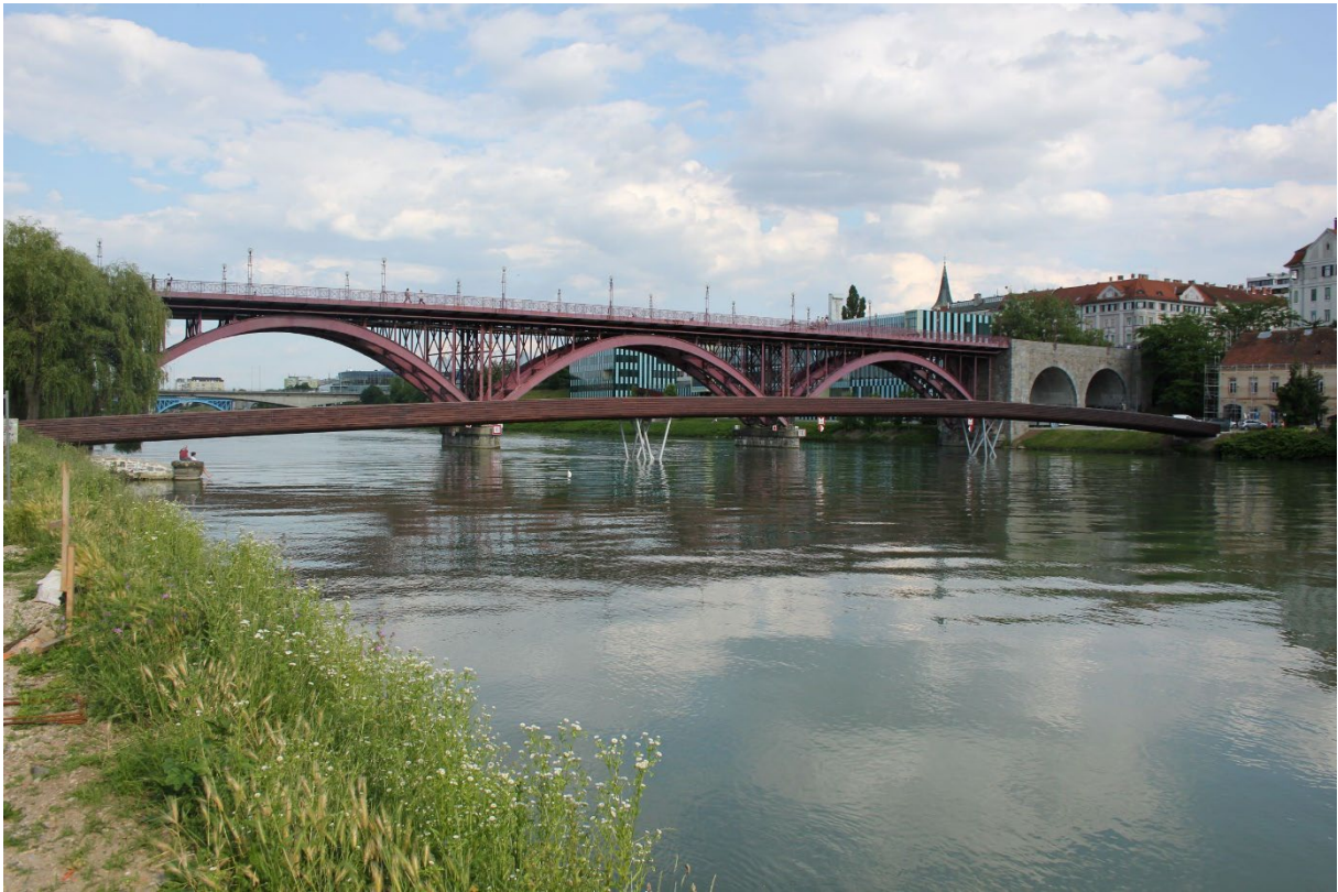
Abbildung 71...über die Baustelle zur Neugestaltung des Drau-Ufers am Lend...
