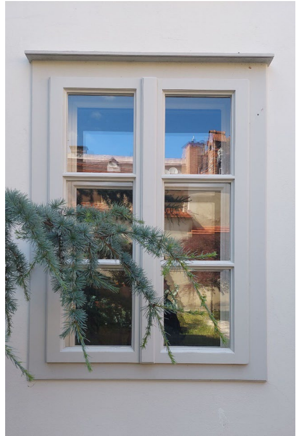
Abbildung 35 Gaißfußfenster - eine ideale Lösung für Grazerstock-Fenster
