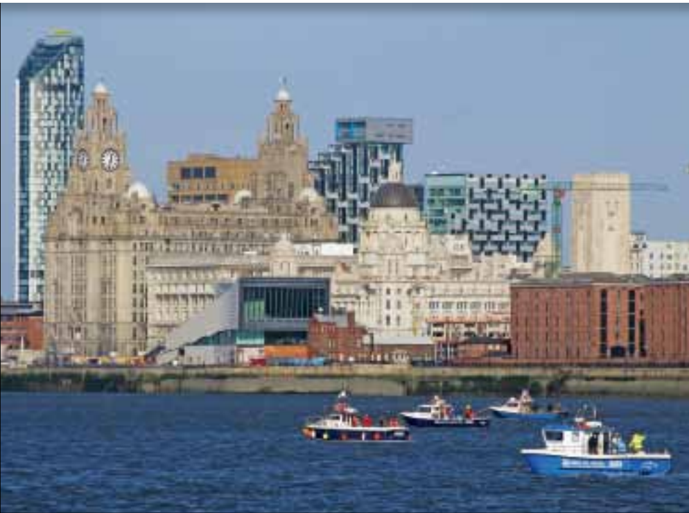
Die historischen Docks von Liverpool. Liverpool's historic Waterfront.
